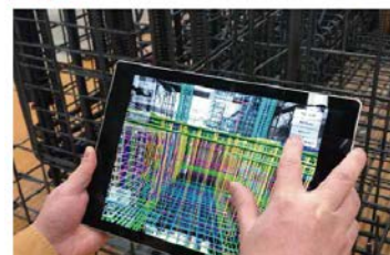
タブレット端末にてBIMモデルと配筋の重なりを確認 BIMモデルは躯体や鉄筋に加え、外装や内装などのモデルに切り替え可能。モデルの現場内空間上に指示・検査記録を貼り付け可能
