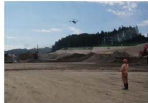
UAV（ドローン）による写真測量
